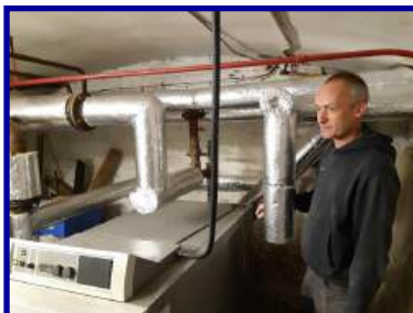
Lagging boiler pipes
